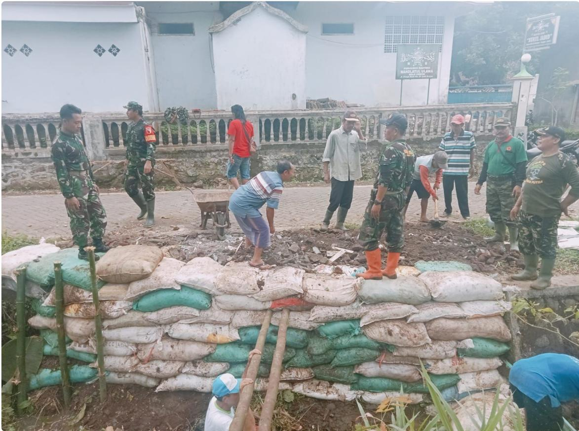
Pembersihan saluran irigasi sepanjang 200 meter tersebut sekaligus melakukan pembenahan plengsengan sungai yang jebol sepanjang 10 meter dengan tinggi 3 meter.
